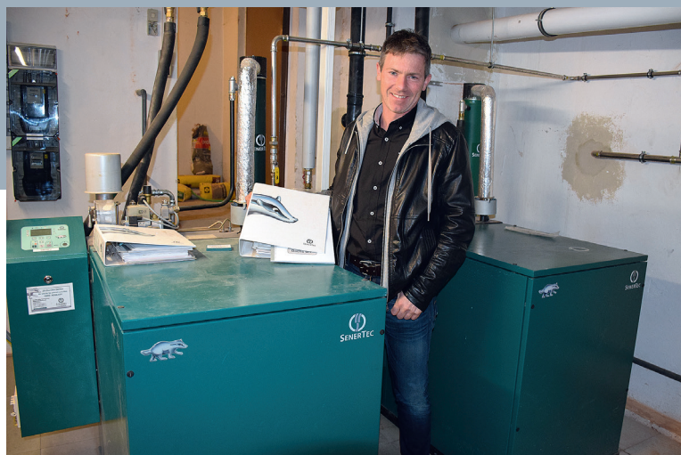
Energieberater und Investor Dipl.-Ing.(FH) B. Jungbauer im Keller des Augustiner Wohnheims, wo das innovative Herz schlägt, die Dachs-Heizung.
